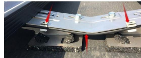
Korrekt befestigte DC-Verkabelung
